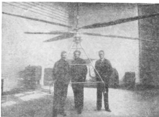
Модель привязного электровертолета соосной схемы А. Г. Иосифьяна. В центре группы А. Г. Иосифьян
