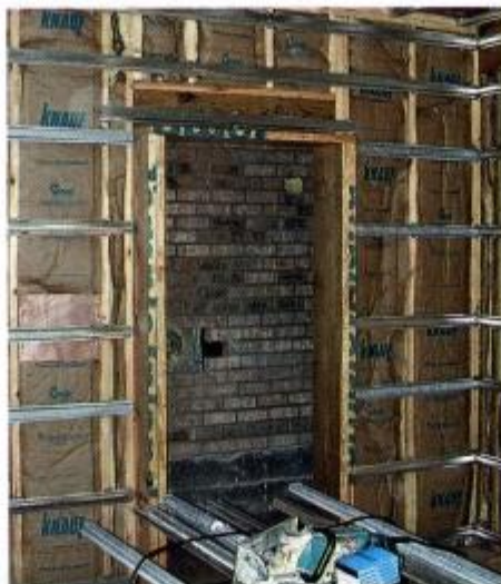
Вот так выглядит стена, подготовленная к установке звукопоглощающих пластин
