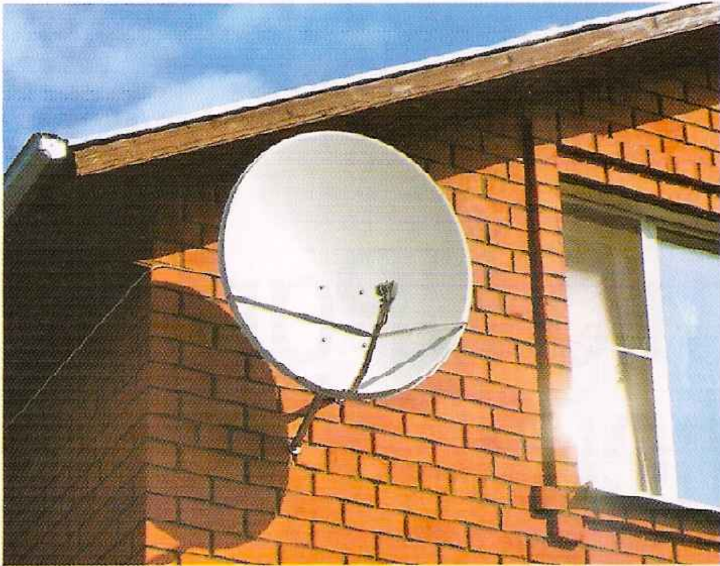
Оффсетная антенна устанавливается практически вертикально, а значит, можно разместить ее на стене дома.
