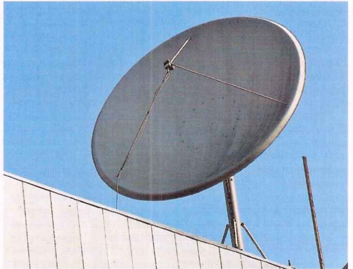
Оптимальный выбор для нашей местности - офсетная антенна радиусом около метра-полутора. Желательно из алюминия.
