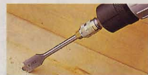
Drill a conduit opening
