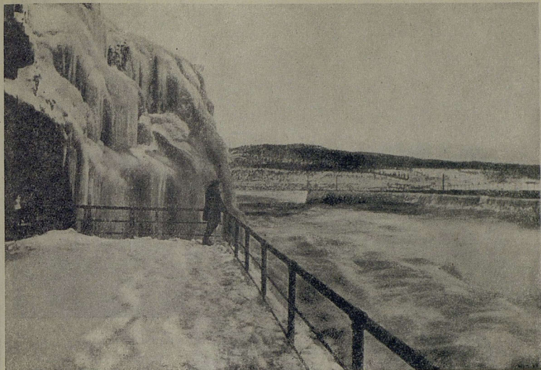
На реке Туломе построена самая северная полярная гидроэлектростанция. Первая турбина ее уже дает ток Мурманску. На снимке — отводящий канал водосброса.
