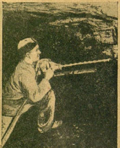
Бурение электробуром в отвальной шахте № 1.
