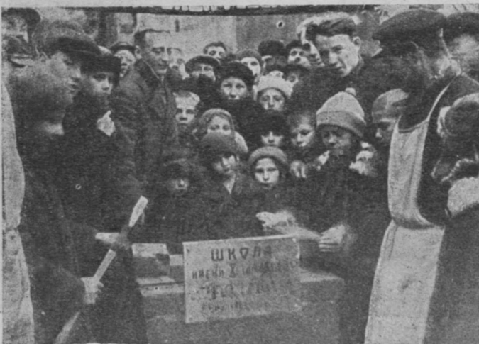
В дни Октябрьских праздников мы торжественно закладываем новые здания фабрик, заводов, школ. На фотографии закладка школы имени десятой годовщины Октября
