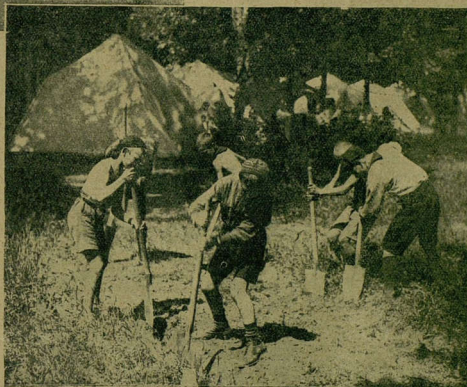
Работа на площадке
