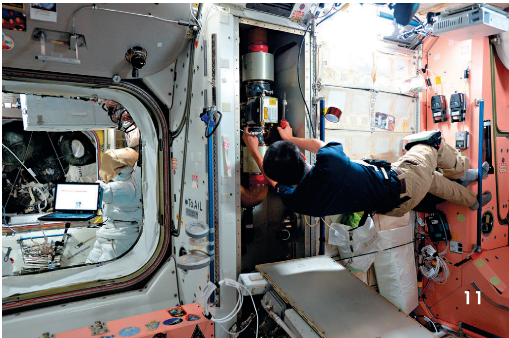
▼ Такуя Ониси чистит систему вентиляции в модуле Unity
