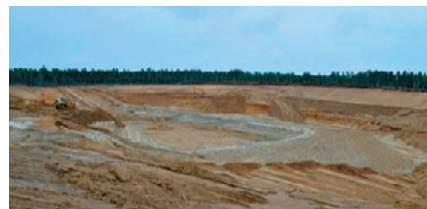
▲ Стартовый комплекс. Разработка котлована
