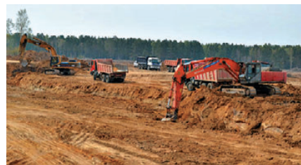
▲ Технический комплекс. Земляные работы
