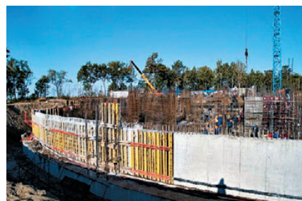
▲ Фундамент административного здания
