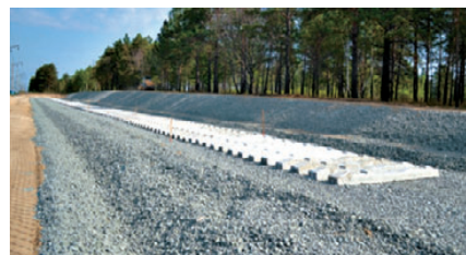
▲ Железная дорога Углегорск – Промышленная-1. Укладка шпал
