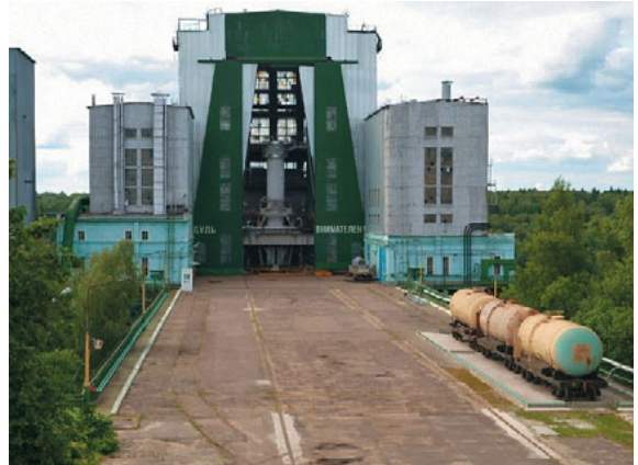
▲ Подготовка к огневым испытаниям блока УРМ-1 в НИЦ РКП (г. Пересвет)
