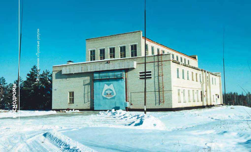
▲ Монтажно-испытательный корпус подготовки РН
