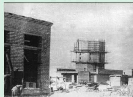
Строительство антенны комплекса «Сатурн-МС». 1967 г.
