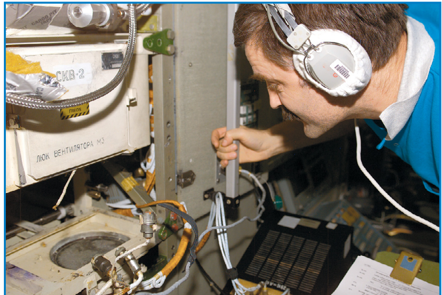
Бортинженер занимается заменой теплообменника в системе СКВ2
