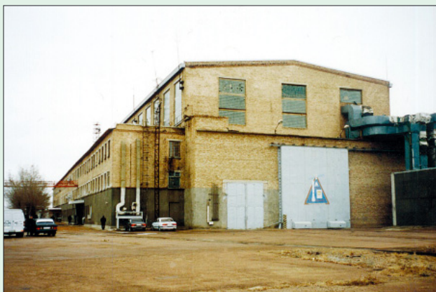
Монтажно-испытательный корпус пл. 31
