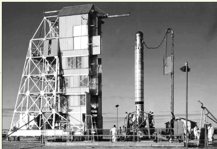
Ракета Black Knight до установки (запуск BK-15) с необычной сферической головной частью
