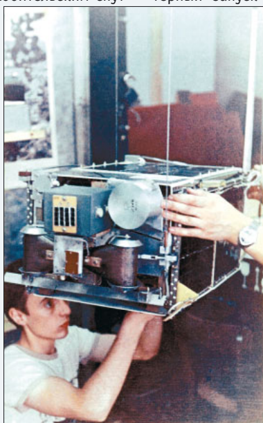
Монтаж второго спутника МАИ
