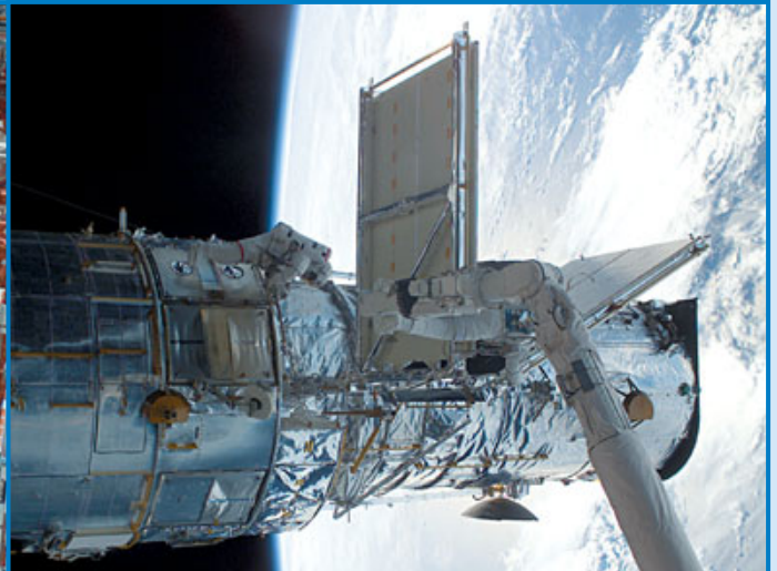
Монтаж новой солнечной батареи
