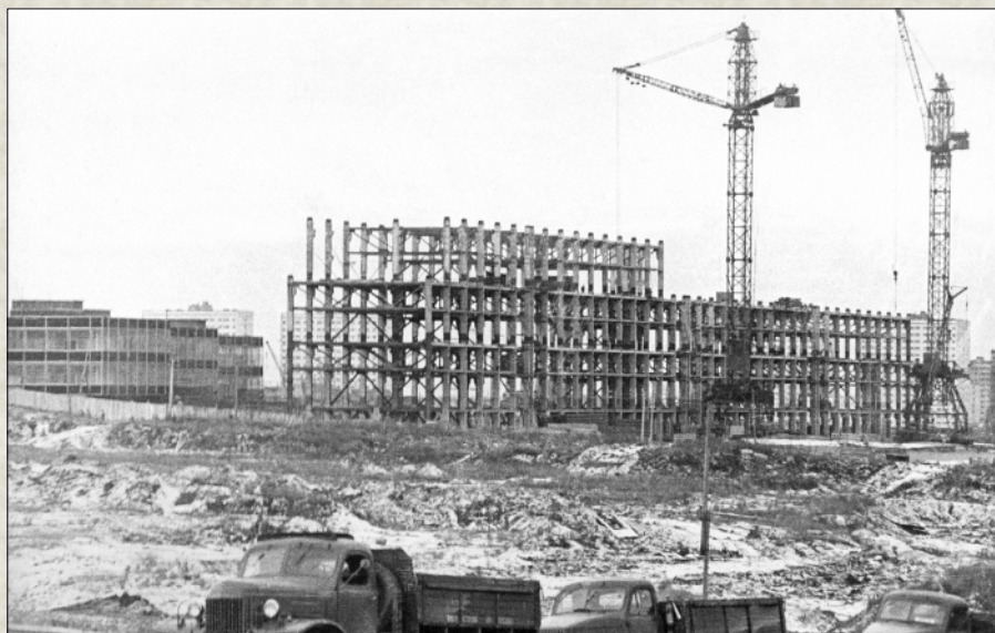
Монтаж главного корпуса
