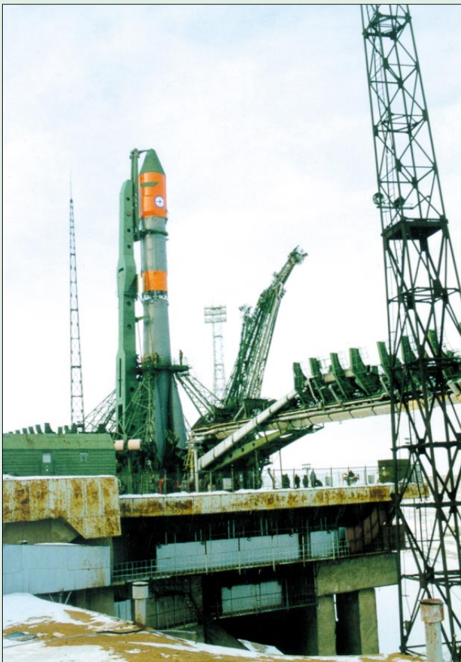
Стартовый комплекс РН типа «Союз» на 31-й площадке
