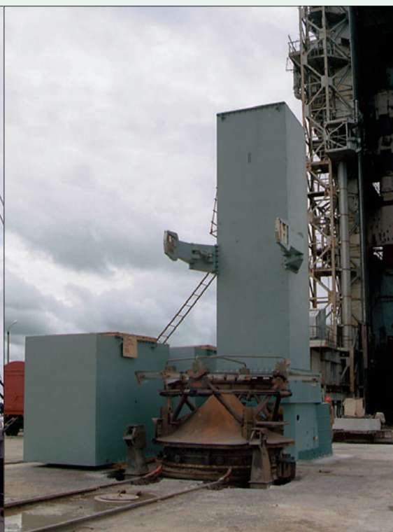
Модернизация стационарной колонны пусковой установки РН «Рокот»
