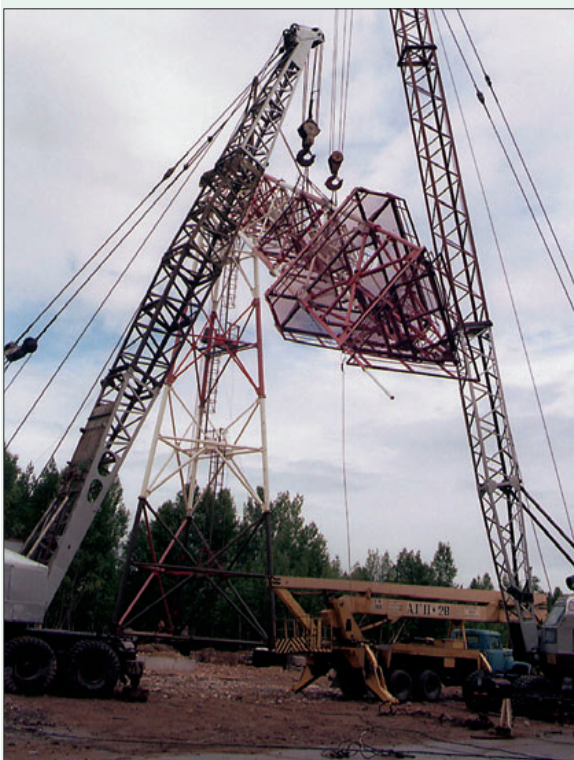
Монтаж телеметрической вышки на ТК
