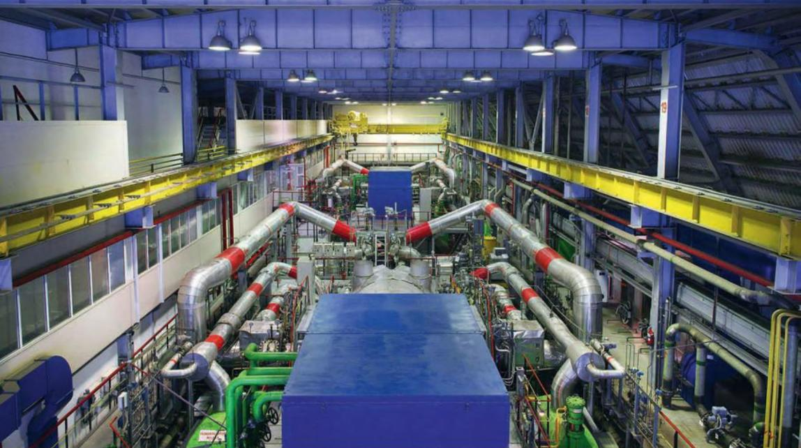
Энергия вулкана превращается в электричество в машинном зале, где пар под высоким давлением вращает турбину, а та заставляет генератор вырабатывать ток
