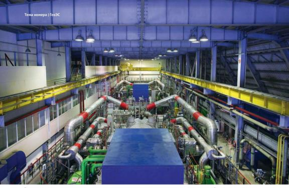
Энергия вулкана превращается в электричество в машинном зале, где пар под высоким давлением вращает турбину, а та заставляет генератор вырабатывать ток
