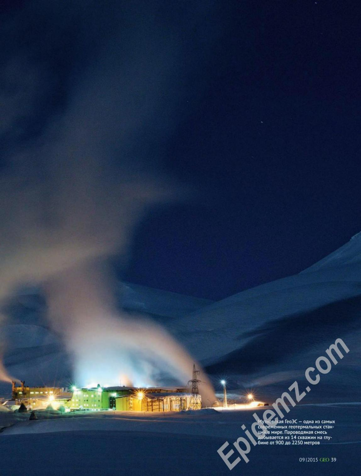
Мутновская ГеоЭС — одна из самых современных геотермальных станций в мире. Пароводяная смесь добывается из 14 скважин на глубине от 900 до 2250 метров
