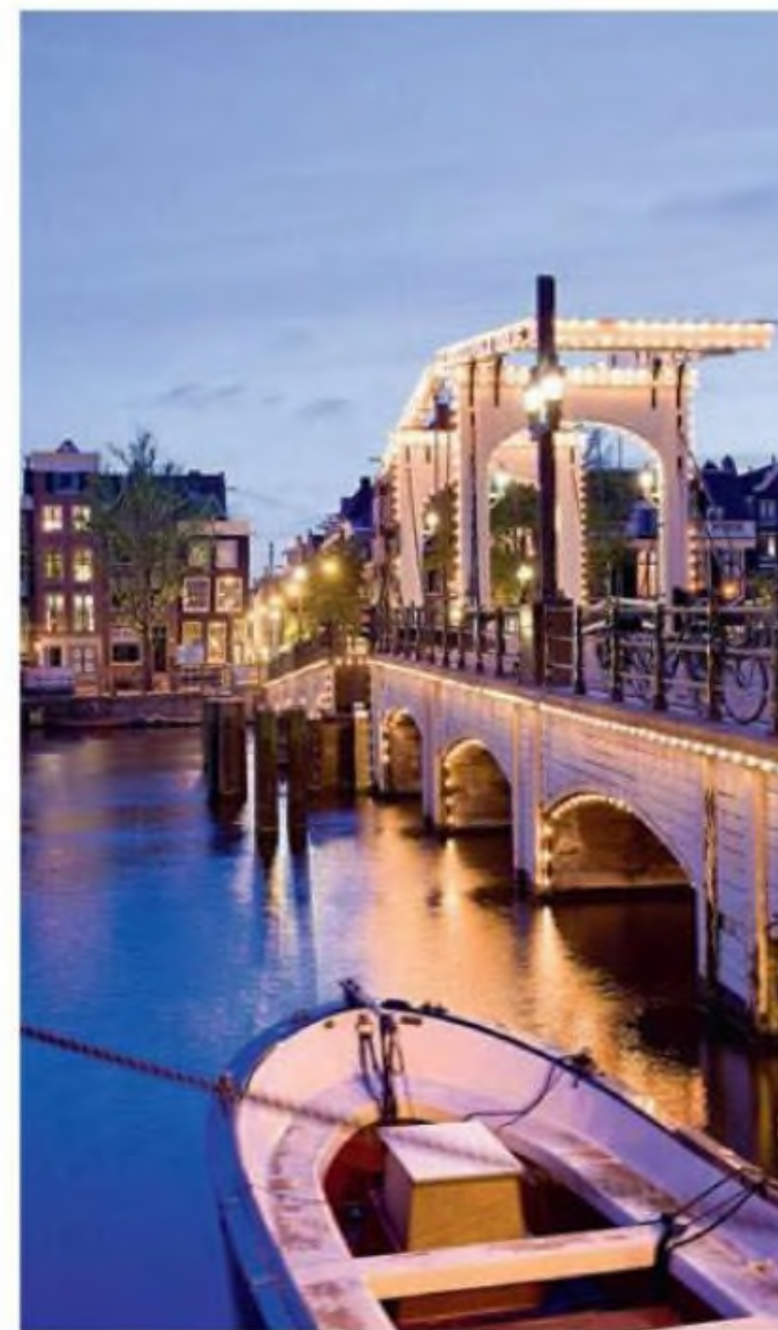
Единственный сохранившийся деревянный разводной мост Магере-Брюг — один из 1300 мостов над каналами Амстердама
