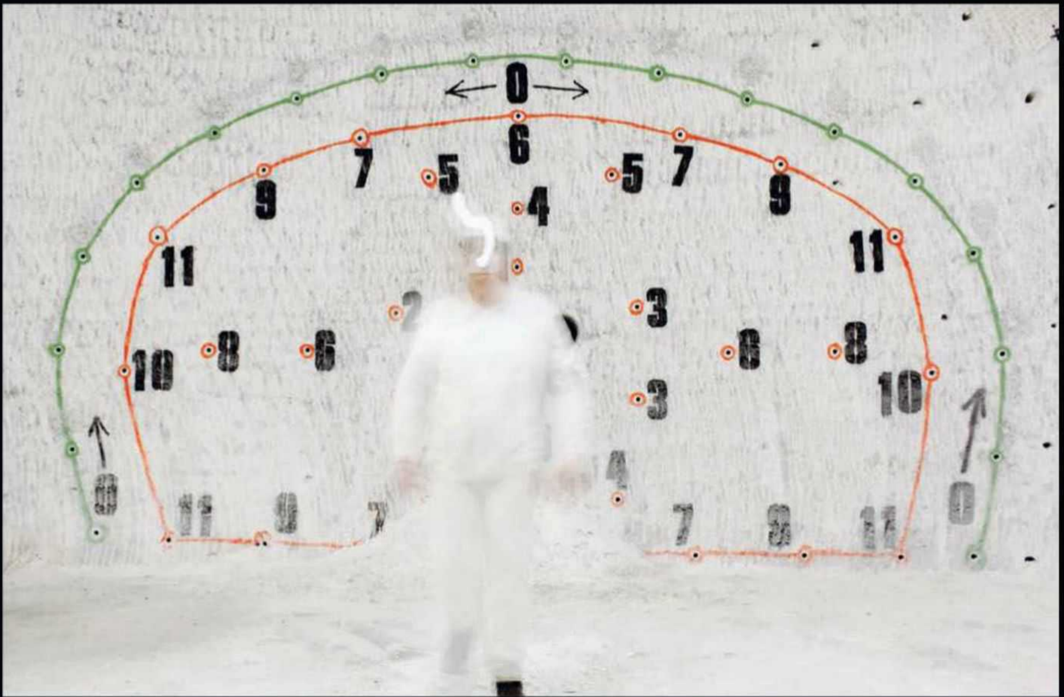
Германия: скважины для закладки взрывчатки в подземных пластах каменной соли в Горлебене. Здесь на глубине 840 метров прокладывается система туннелей, предназначенных для хранения ядерных отходов
