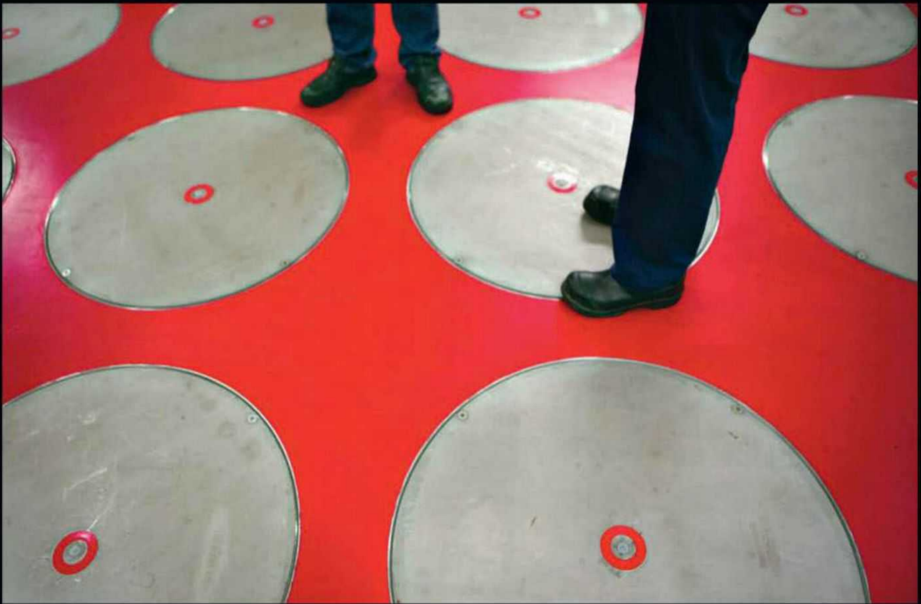
Нидерланды: хранилище ядерных отходов COVRA. В бетонных колодцах под круглыми люками скрываются кассеты с отработанными топливными стержнями и ядерные отходы, вплавленные в стекло
