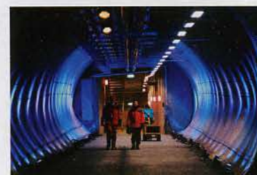
Стены тоннеля, ведущего в хранилище, усилены метровым слоем железобетона.
