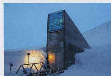
Вход в тоннель выполнен по всем правилам строительства бомбоубежищ.
