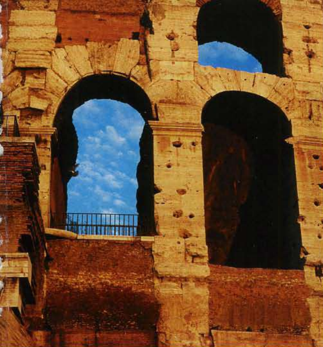
Слева: Галереи римского Колизея (I век н. э.), выполненные из бетона и кирпича. Справа: Марио Кандор, сотрудник немецкой компании BASF , и его изобретение: водонепроницаемые кирпичи, покрытые полимерным материалом. Они не «промокают» даже в том случае, если не подвергаются обжигу.
