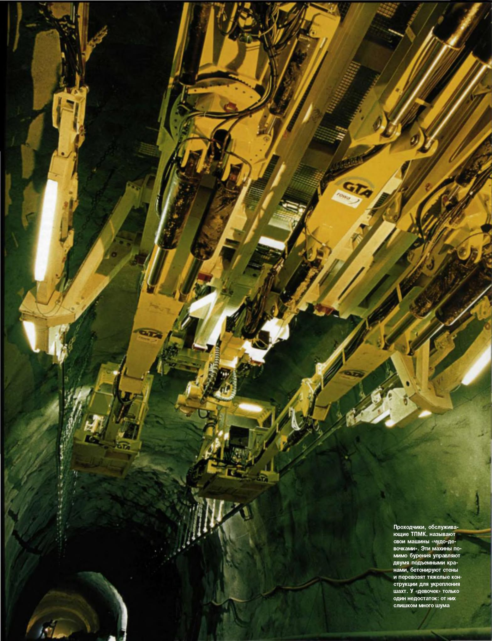
Проходчики, обслуживающие ТПК, называют свои машины «чудо-девочками». Эти машины помимо бурения управляют двумя подъемными кранами, бетонируют стены и перевозят тяжелые конструкции для укрепления шахт. У «девочек» только один недостаток: от них слишком много шума
