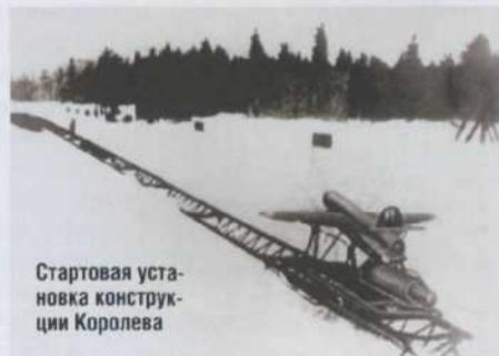
Стартовая установка конструкции Королева
