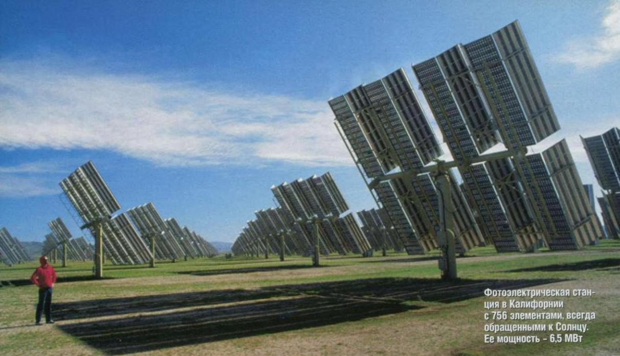
Фотоэлектрическая станция в Калифорнии с 756 элементами, всегда обращенными к Солнцу. Ее мощность – 6,5 МВт
