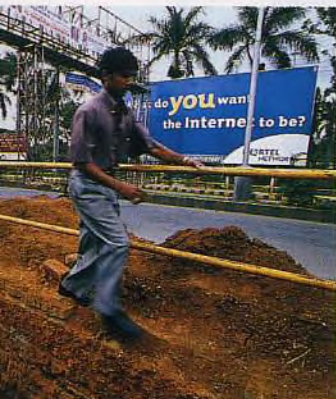
Пробраться по бангалорским улицам не так просто – кругом все время прокладывают кабель.
