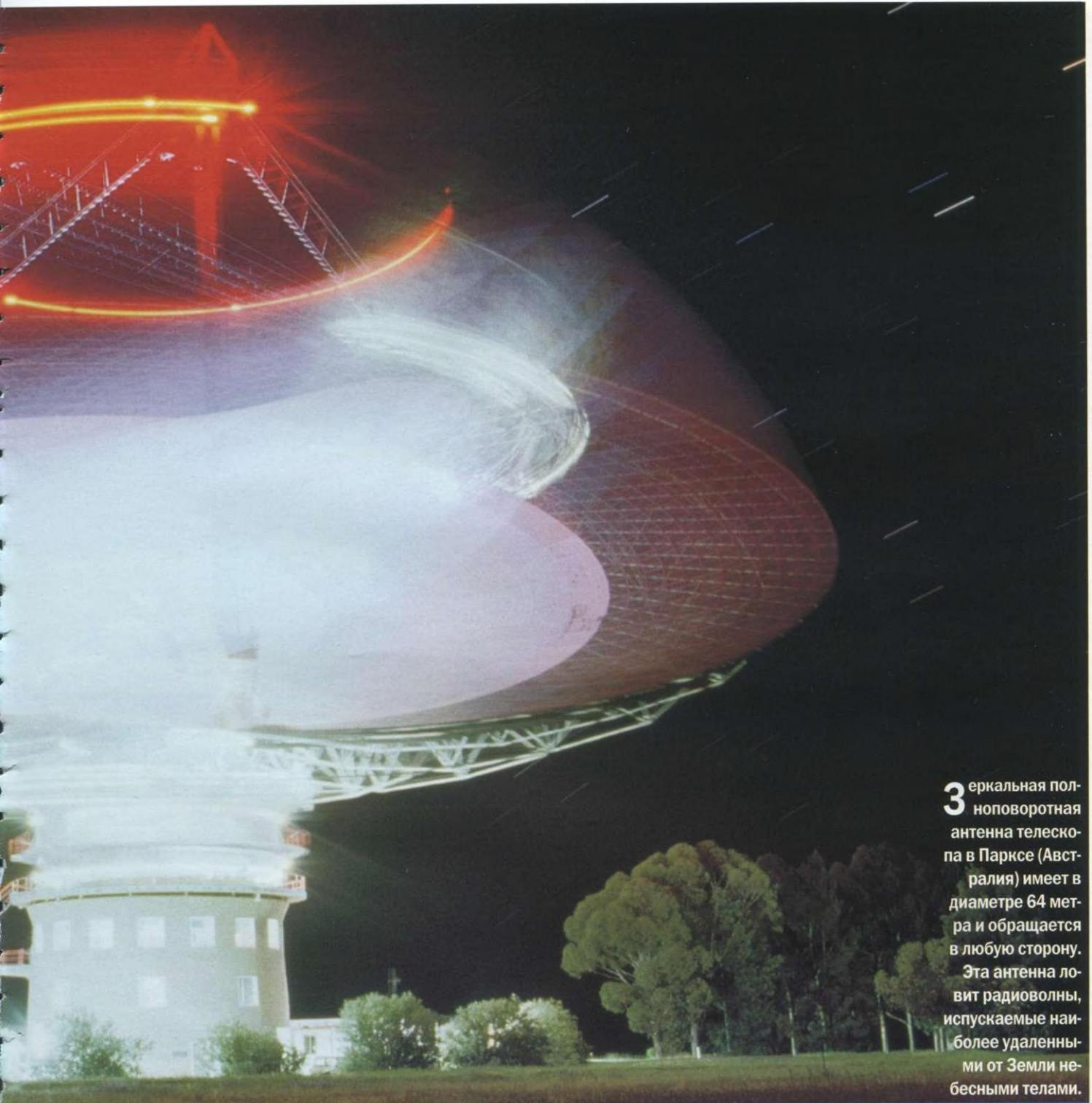
**З**еркальная полноповоротная антенна телескопа в Парксе (Австралия) имеет в диаметре 64 метра и обращается в любую сторону. Эта антенна ловит радиоволны, испускаемые наиболее удаленными от Земли небесными телами.
