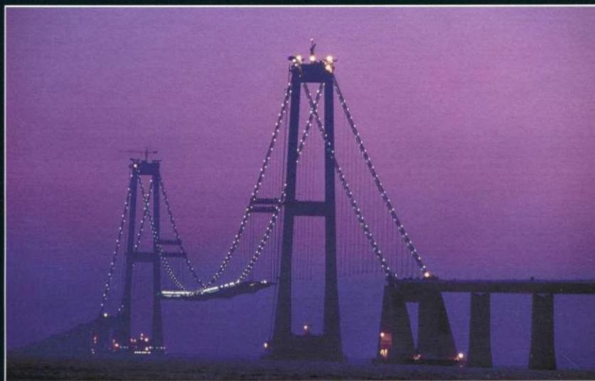
«Сторелбелт» – это построенная в Дании система виадуков между острова Зеландия и Фюн. Она состоит из двух мостов и железнодорожного тоннеля. Один из мостов, «Ист-Бридж» (снимок справа), – самый длинный подвесной мост в мире. Длина главного пролета составляет 1624 метра.
