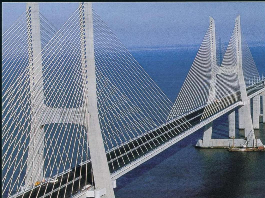
На строительство лиссабонского моста ушло 730 тысяч кубометров бетона и 100 тысяч тонн стали. В случае землетрясения центральный пролет выдержит колебания с амплитудой более метра.
