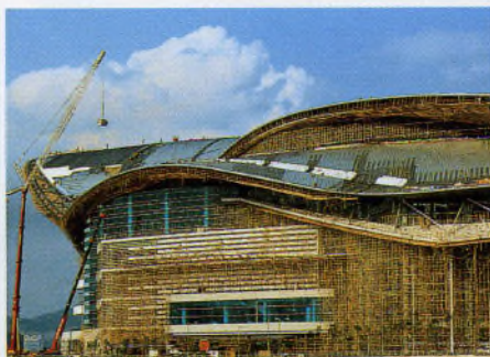
Бамбук идеально подходит для возведения лесов на крупных стройках.
