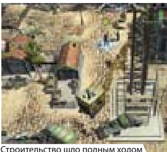
Строительство шло полным ходом
