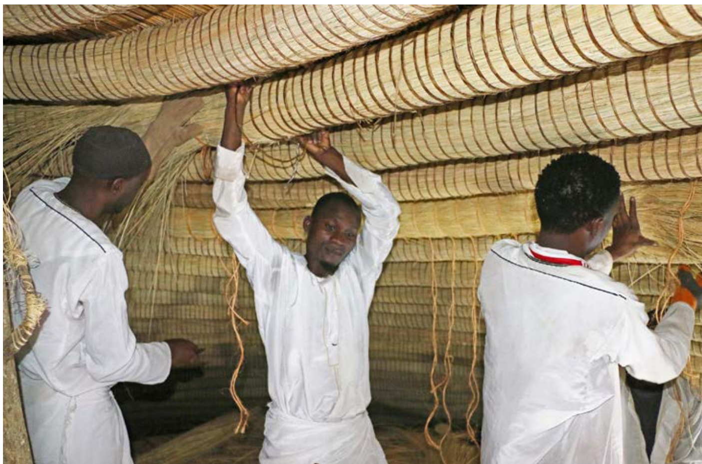
▼ Мастера укрепляют соломенную крышу одного из зданий комплекса кольцами из тростника.
