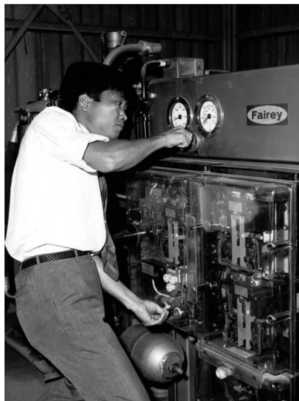
Студент имитирует землетрясение на гидравлическом вибростенде, Япония, 1969 г. Испытания проводятся в рамках проекта, осуществляемого совместно правительством Японии и Программой развития ООН под координацией ЮНЕСКО и направленного на подготовку сейсмологов из развивающихся стран по вопросам смягчения последствий землетрясений.
