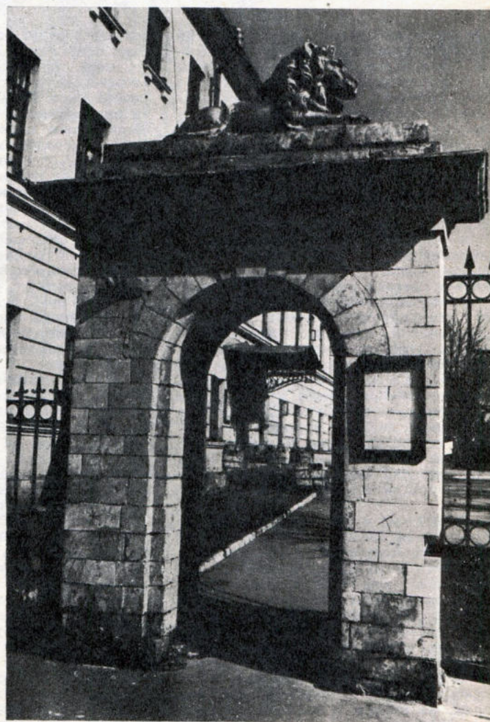
Входная арка и флигель бывшей Марининской больницы в Москве. Скорее арку видно крыльцо — вход в квартиру при больнице, которую занимал штаб-лекарь ее М. А. Достоевский с семьей. Сейчас весь флигель, где находились комнаты Достоевских, отведен для музея-квартиры Ф. М. Достоевского.
