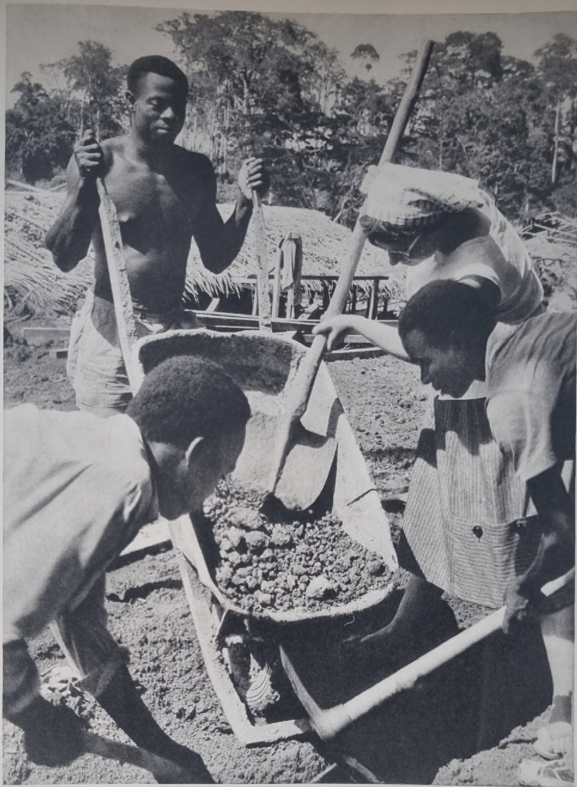
Юноши из Камеруна и Кении и девушка из Нидерландов работают в лагере трудовой взаимопомощи: они строят водопровод для нового общинного центра в Республике Камерун.
