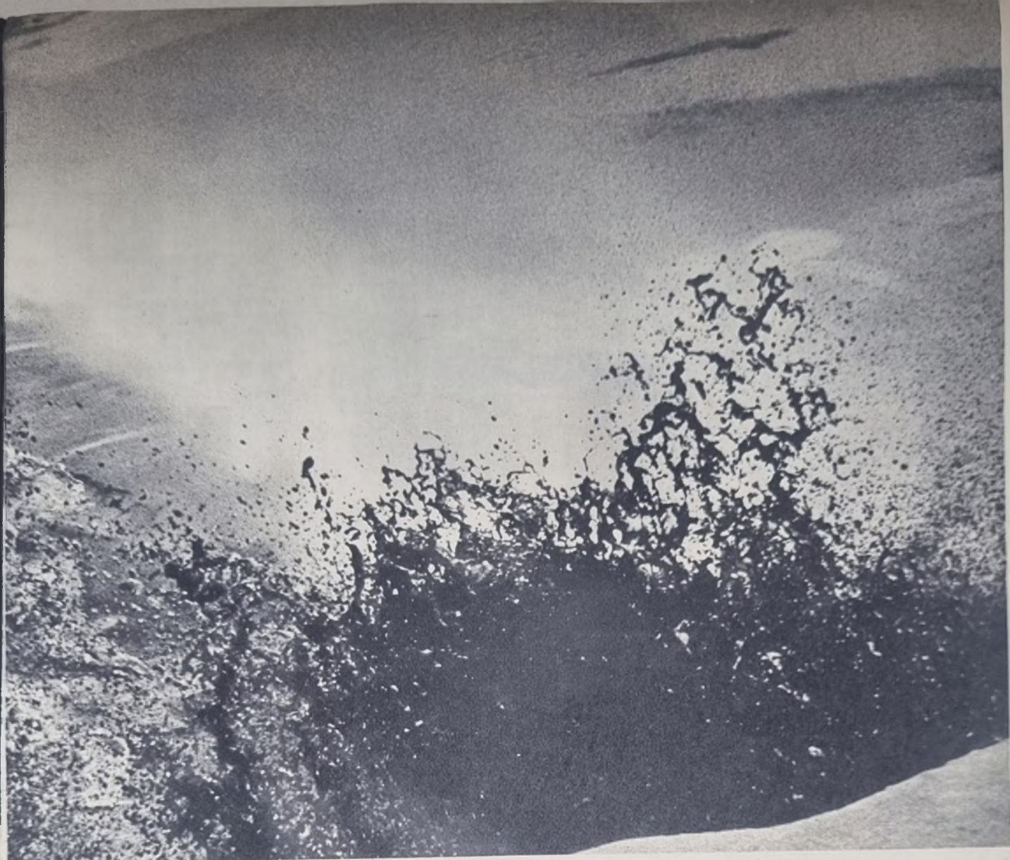
Сильная струя воды гидромонитора размывает и сносит песчаный бархан (Узбекская ССР).
