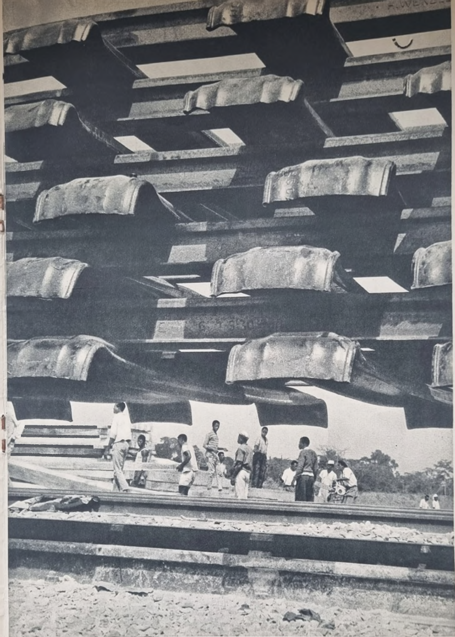
Строительство шоссейных и железных дорог открывает путь экономическому развитию, содействуя расширению торговли и экспорту сырья. На снимке: строительство железной дороги в Конго; по ней марганцевая руда из соседней с Конго Республики Габон будет доставляться в морские порты на западном побережье Африки.
